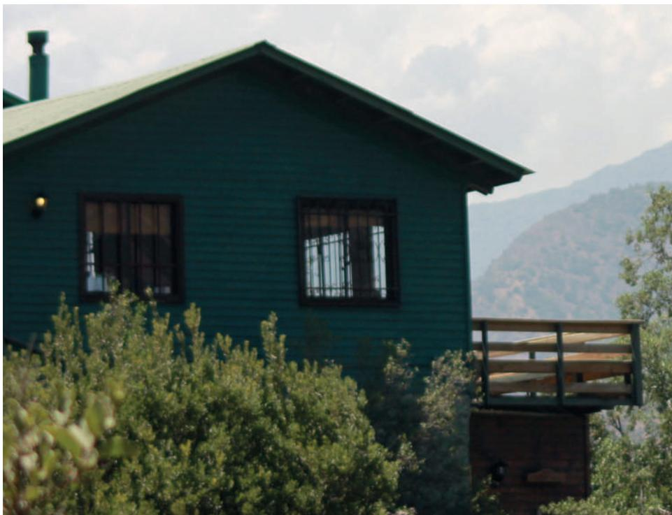
Figura 23. Revestimiento horizontal.
